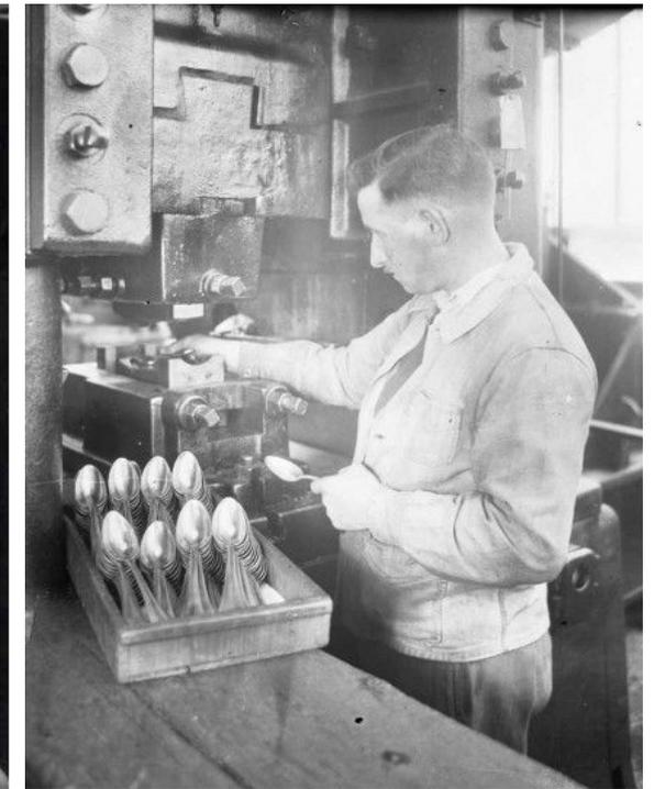
Fig 9. Technicien responsable d'une presse hydraulique de forge du site Christofle, ici avec un moule de cuillère, milieu du XX<sup>e</sup> siècle.
